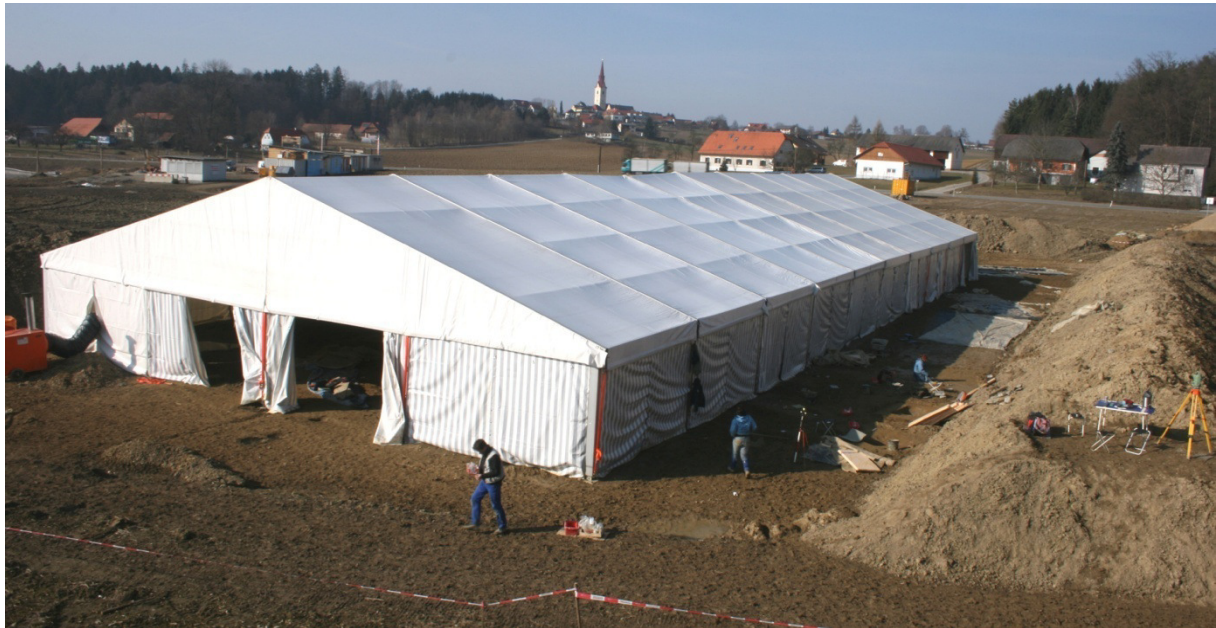
Abb. 13: Schönberg, Grst.Nr. 301, beheizbare Zelthalle für die Winterarbeit, Ansicht gegen Nord, Foto ARGIS, 18.02.2008.
