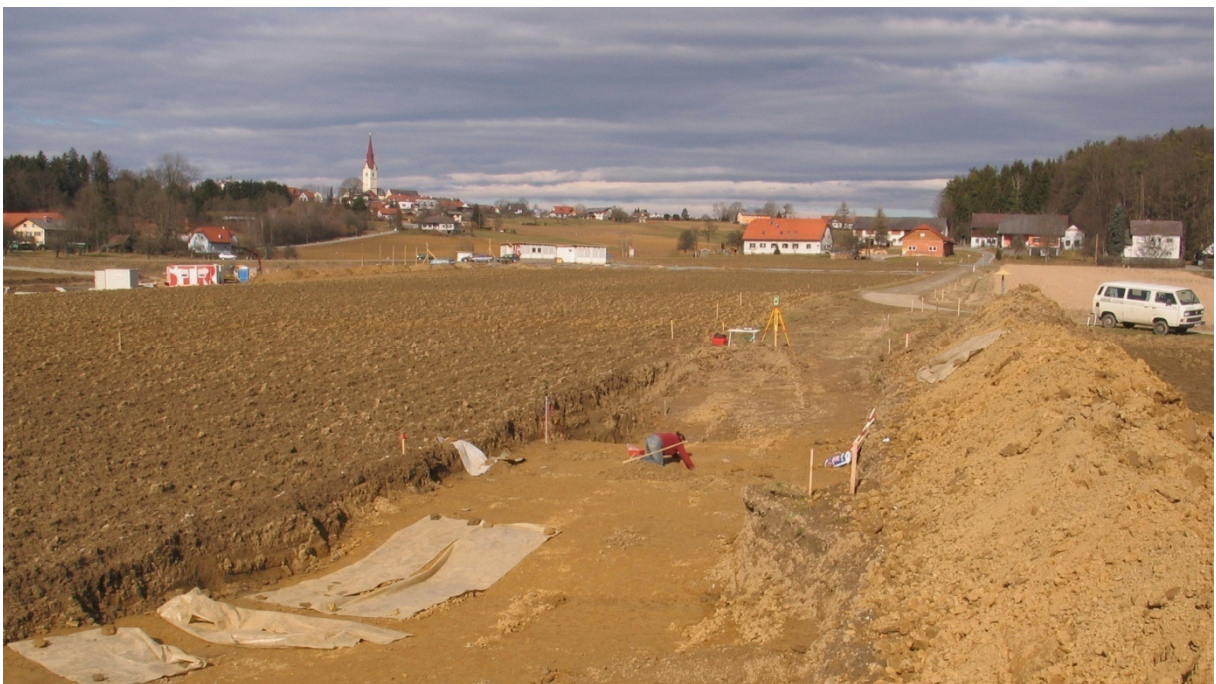
Abb. 5: Schönberg, Grabung 2007, Rettungszufahrt, Ansicht gegen Nord, Foto ARGIS, 16.02.2007.
