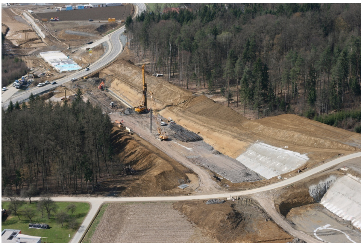
Abb. 2: Schönberg, Hengsborgtunnel im Bau (offene Bauweise im Südteil). Luftbild, Ansicht gegen Südwest, ARGIS, 25.03.2008.
