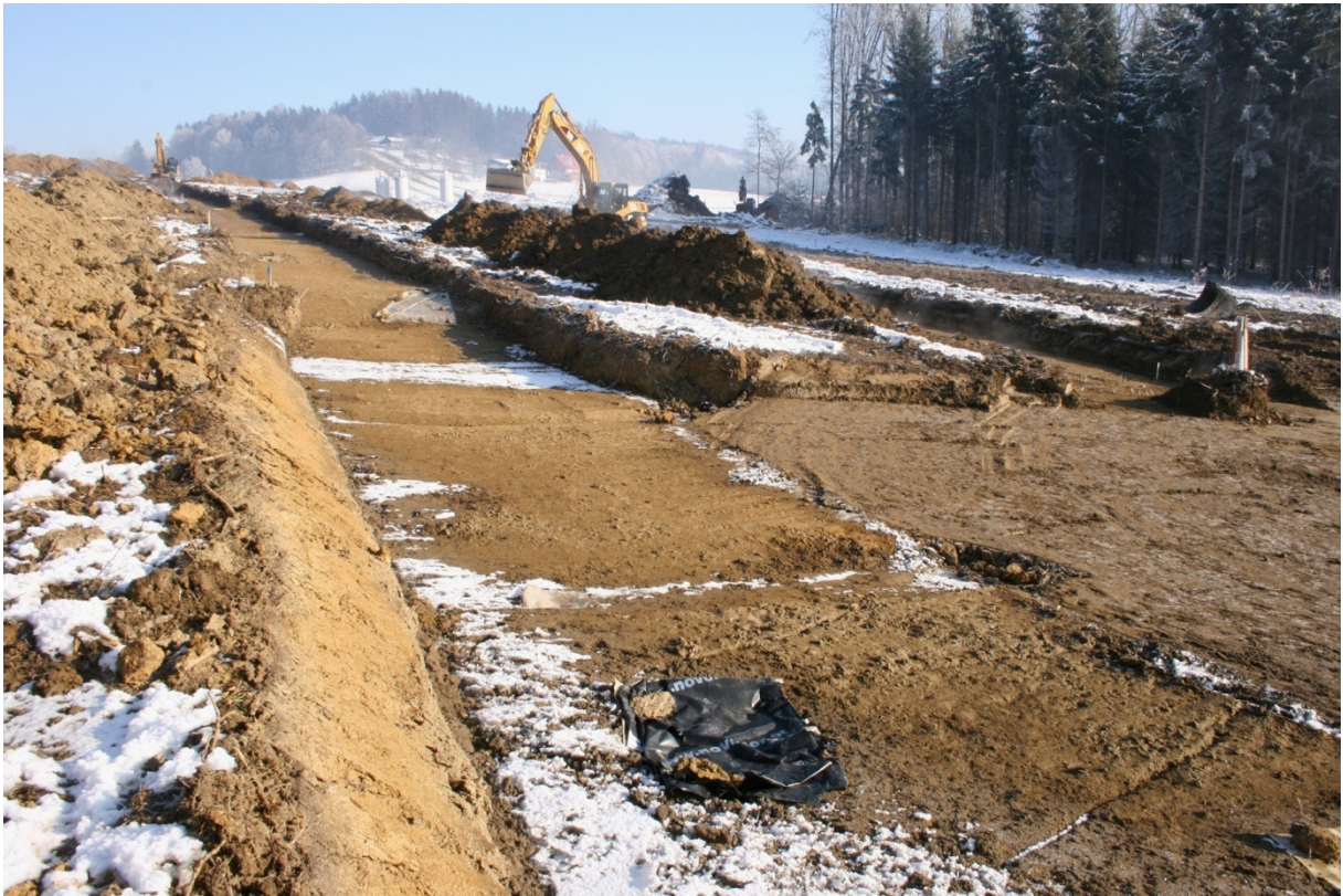
Abb. 11: Schönberg, Hengsbergtunnel, offene Bauweise, Grabung 2008 im ehemaligen Waldgebiet, maschinelle Sondierungen im oberen Hangbereich, Foto ARGIS, 08.01.2008.
