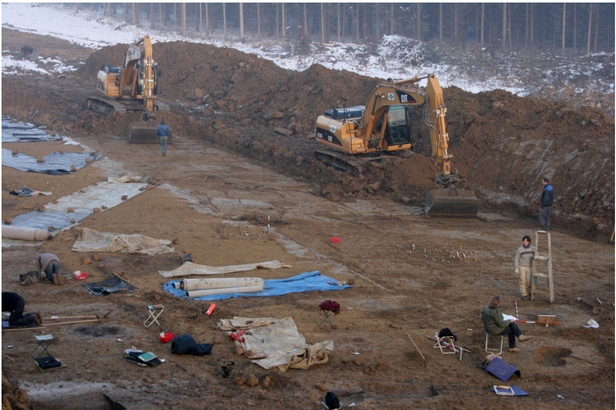
Abb. 10: Schönberg, Hengsbergtunnel, offene Bauweise, Grabung 2008 im ehemaligen Waldgebiet, Foto ARGIS, 07.01.2008.
