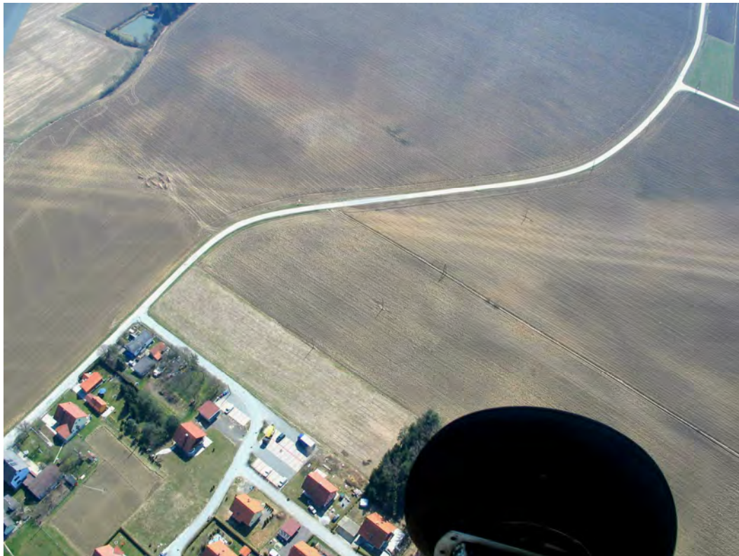
Abb. 1: KG Schrötten, unten die Baierdorfsiedlung, in Bildmitte als helle lineare Bodenmerkmale die drei Stränge der Trans-Austria-Gasleitung (TAG), links oben beim Fischteich der Barbach (= Grenze zur KG Schönberg). Zustand vor Baubeginn, Ansicht gegen Südost, Luftbild ARGIS, 03.04.2005.
