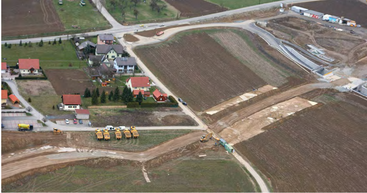
Abb. 2: KG Schrötten, links die Baierdorfsiedlung, rechts die Baustelle des P&R-Parkplatzes beim Bahnhof Hengsberg mit Unterführung und Barbach-Düker, oben die Landesstraße L601, rechts vorne die ersten Grabungsflächen. Ansicht gegen Nord, Luftbild ARGIS, 25.03.2008.
