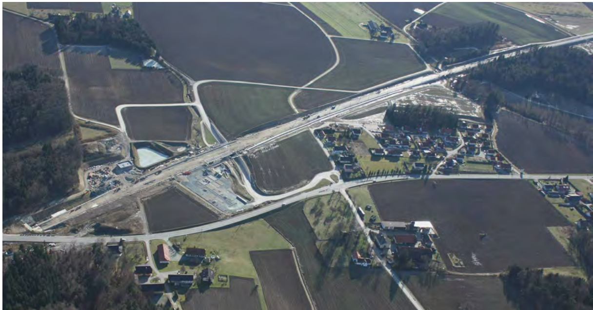
Abb. 3: Schönberg – Schrötten-Ost, Koralmbahn im Bau. Von links nach rechts: Hengsbergtunnel-Südportal mit Querung der Landesstraße L601, Bahnhof Hengsberg mit P&R-Parkplatz, Barbach-Düker und Unterführung, Baierdorfsiedlung. Ansicht gegen Süd, Luftbild ARGIS, 03.01.2010.
