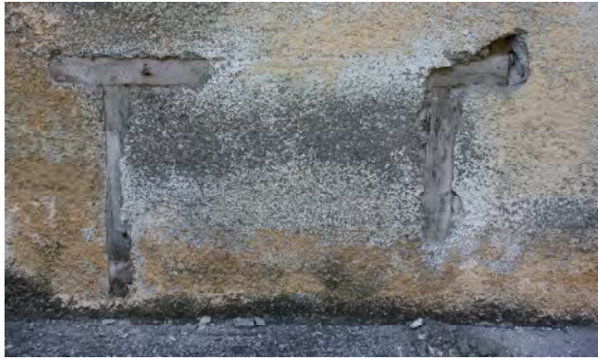
Abb. 104 (links) und Abb. 105 rechts): Vermauertes Fenster.
