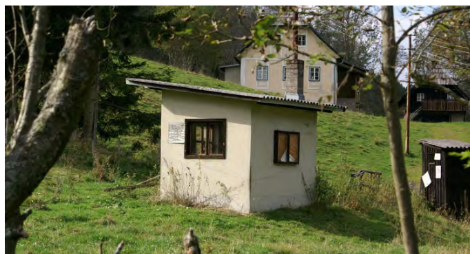
Abb. 93: Fröschnitz 23, Liftwarthaus, Ansicht gegen Nordwest. Foto M. Arneitz.
