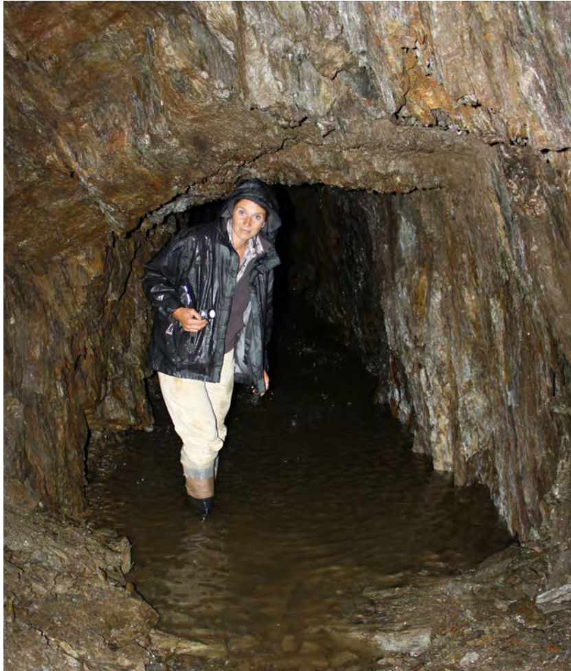
Abb. 16: Peterbauer-Stollen, Ansicht bergwärts. Foto ARGIS, 11.05.2013.
