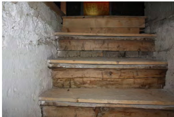
Abb. 163 (links) und 164 (rechts): Raum DG 1.
