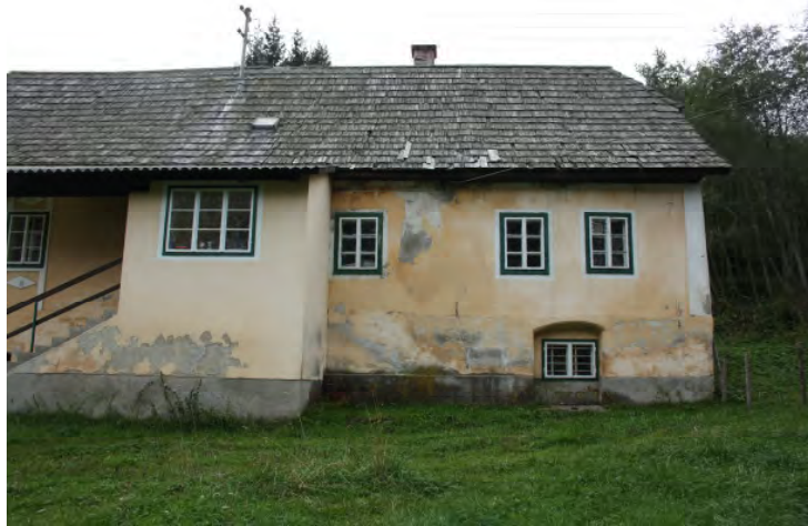
Abb. 94: Ansicht gegen Südwest.
