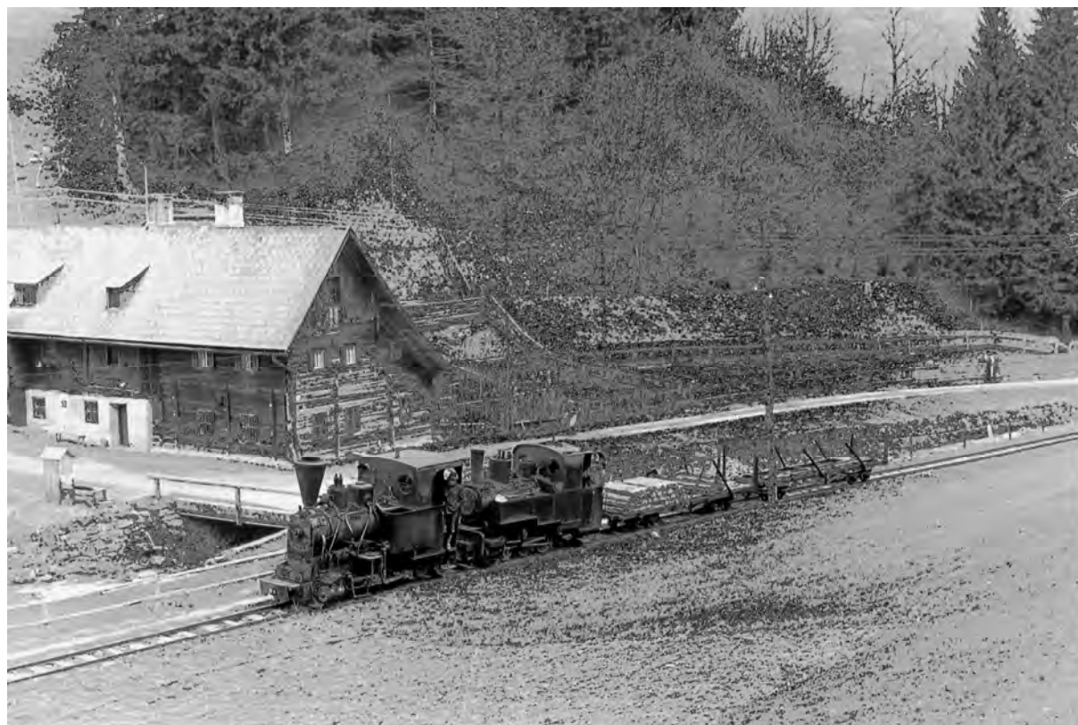
Abb. 247: Zwei Dampflokomotiven (Betriebsnummer 5 und 6) am 6. Mai 1958 vor dem vulgo Hutmann / Grubenhaus. (Copyright Mag. Alfred Luft, Wien; Fotograf: Harald Nave; Archiv VEF, Neg.-Nr. 307-30).
