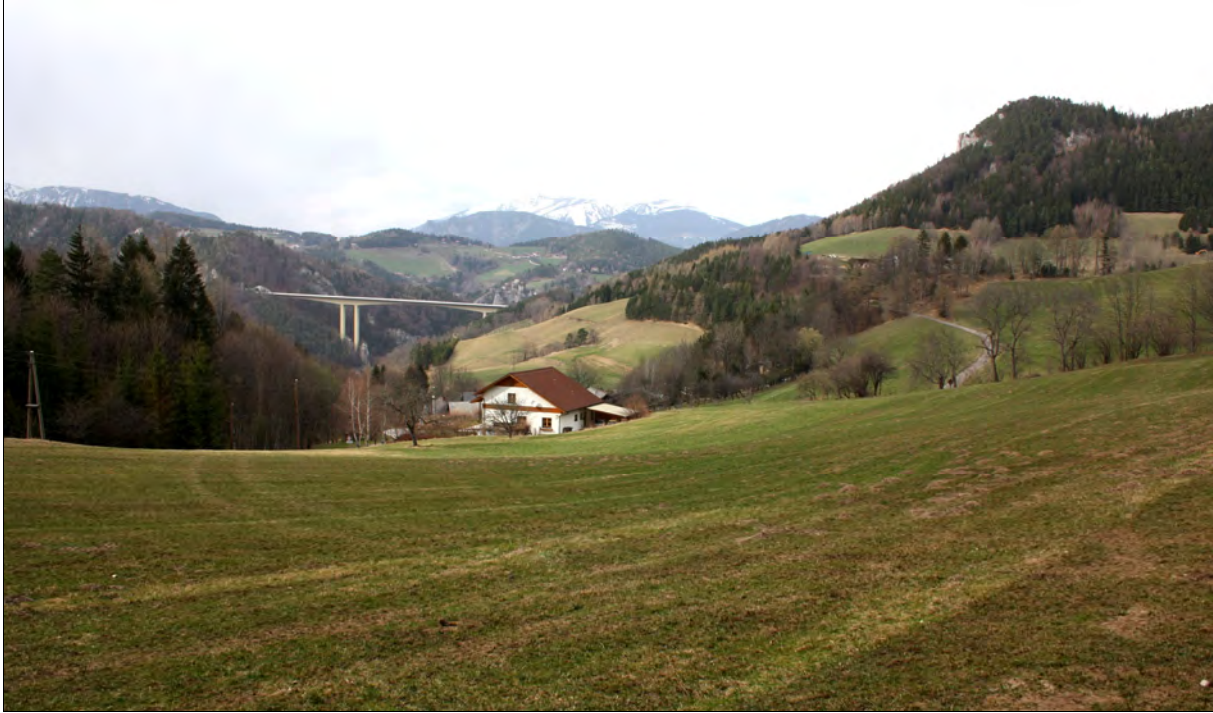
Abb. 5: Zwischenangriff Göstritz, Ansicht gegen Nordwest. Foto ARGIS, 29.03.2012.
