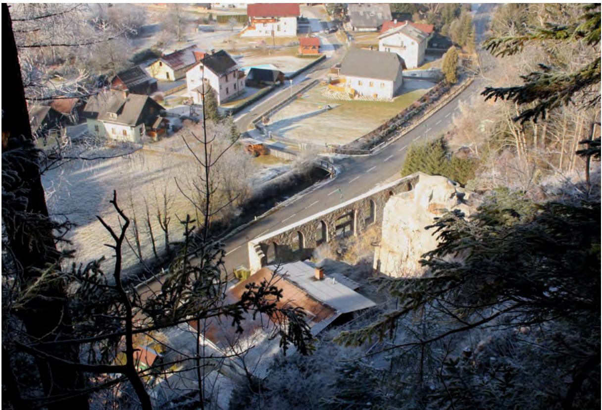
Abb. 8: Steinhaus, Alfred-Hütte mit Hochofen. Foto ARGIS, 02.12.2011
