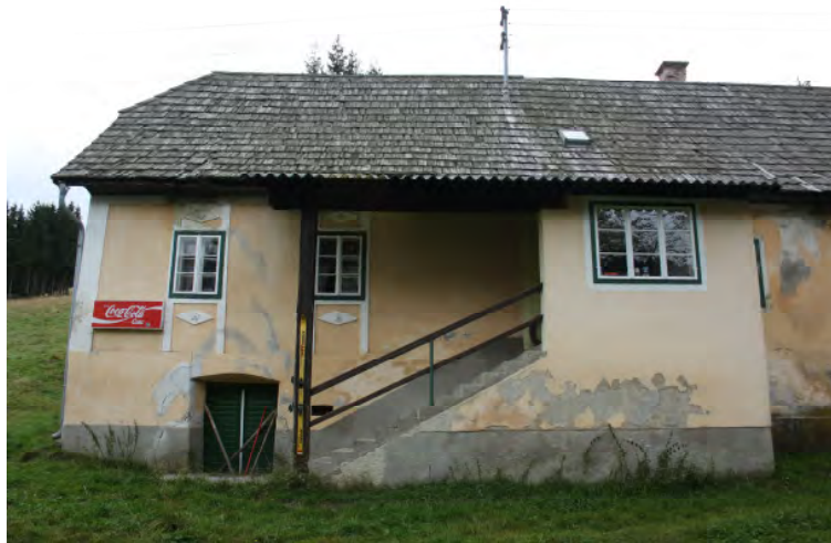
Abb. 95: Ansicht gegen Südwest.
