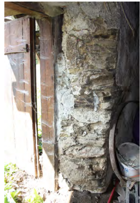
Abb. 193: Raum EG 3, Nähe Ostecke, Türe.
