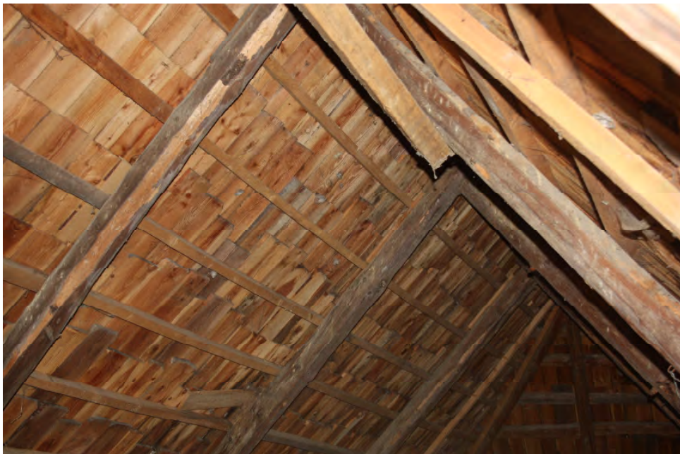
Abb. 170: Raum DG 3, Dachstuhl.
