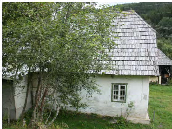
Abb. 99: Ansicht gegen Nordost.
