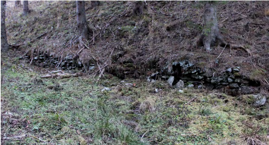
Abb. 19: Bruchsteinmauer im Longsgraben. Foto ARGIS, 28.11.2011.
