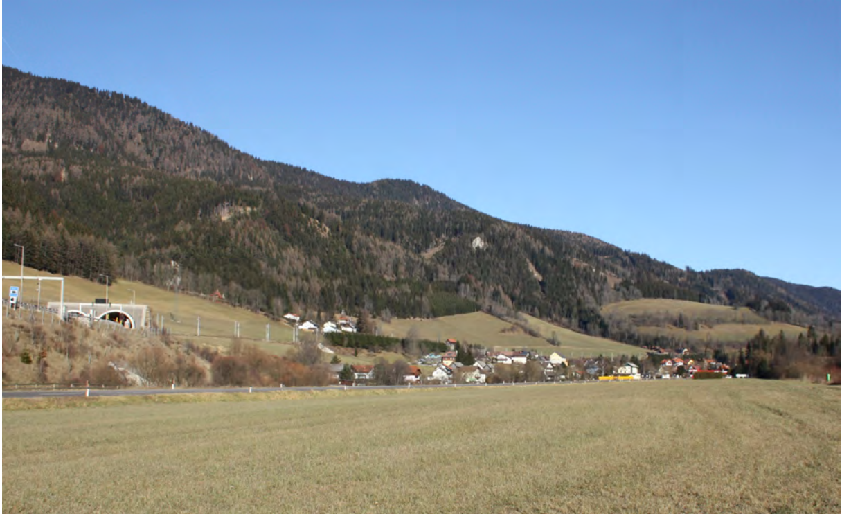
Abb. 7: KG Spital am Semmering, Bereich Zwischenangriff Grautschenhof, Ansicht gegen West. Foto ARGIS, 02.12.2011.
