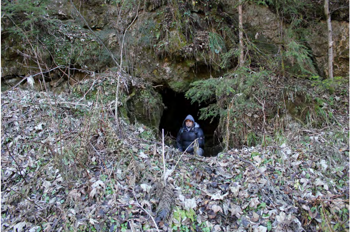
Abb.11: Peterbauer-Stollen, Mundloch neben der Baustraße. Foto ARGIS, 28.11.2011.
