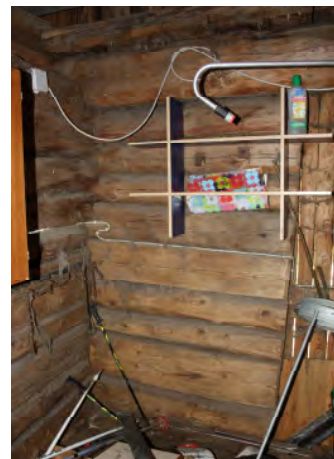
Abb. 203 (links): Raum EG 4; Abb. 204 (rechts): Raum OG 1.
