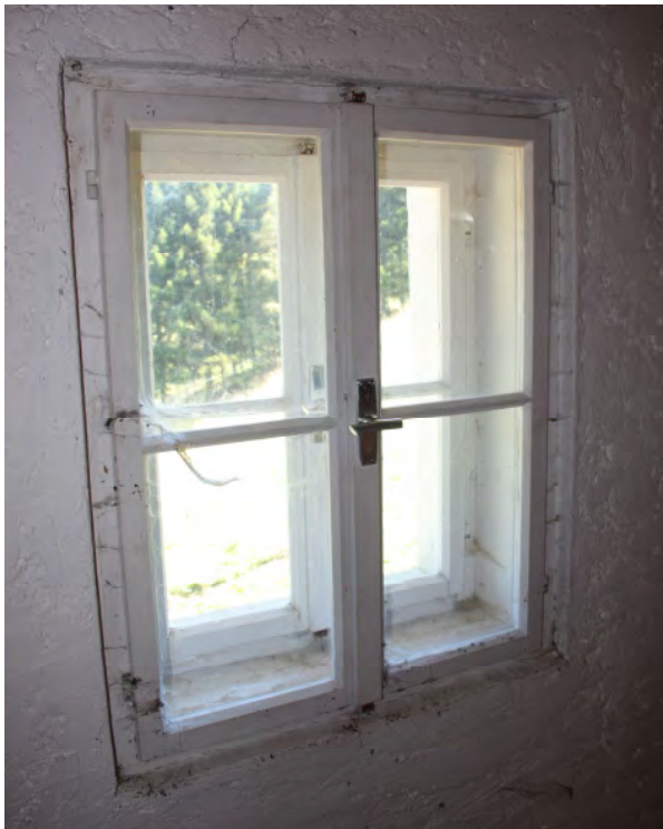
Abb. 172: Raum DG 2, Südostwand, Fenster.
