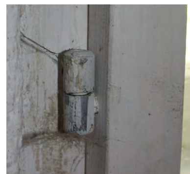
Abb. 173 (oben) und 174 (unten): Raum DG 2, Südostwand, Fenster, Details.
