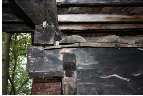
Abb. 218 (links) und 219 (oben): Getreidekasten, Westecke, Obergeschoß.
