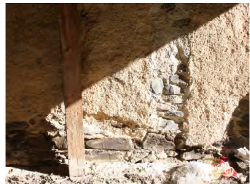
Abb. 198 (rechts): Raum EG 2, Ansicht gegen Südost.
