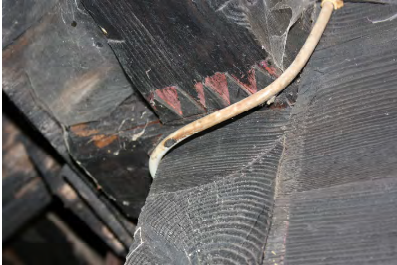
Abb. 223 (links): Südecke, Obergeschoß, Detail.
