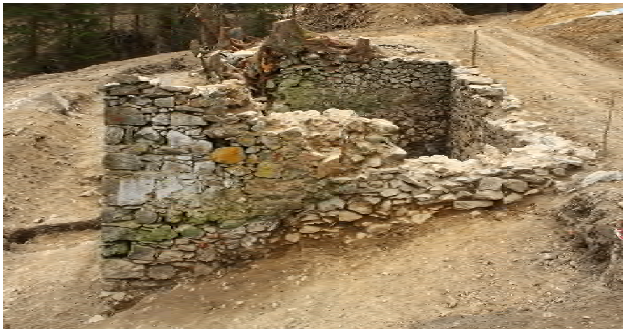
Abb. 55: Objekt 1, Wohnhaus. Ansicht gegen Ost. Foto ARGIS, 27.04.2013.
