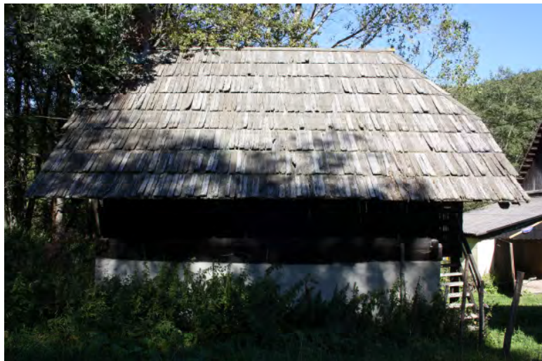
Abb. 210: Getreidekasten, Ansicht gegen Nordost.
