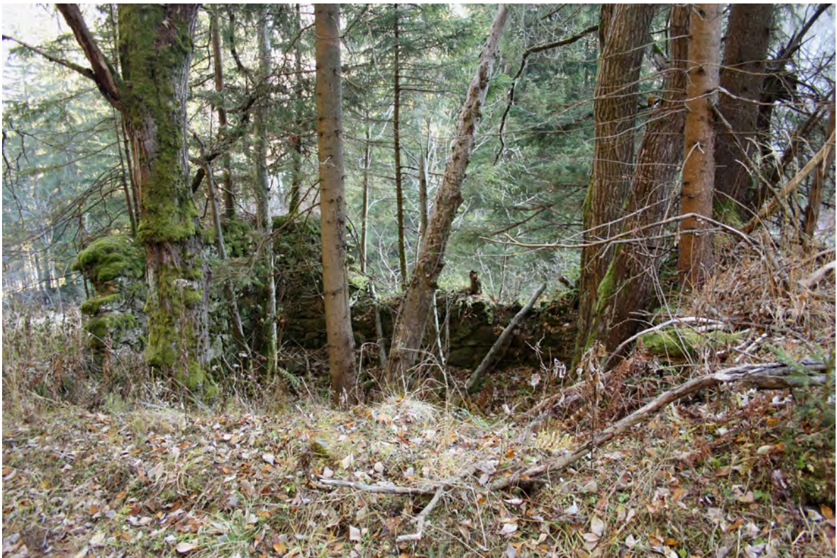
Abb. 12: Gebäuderuine vlg. Nigel. Foto ARGIS, 29.11.2011.
