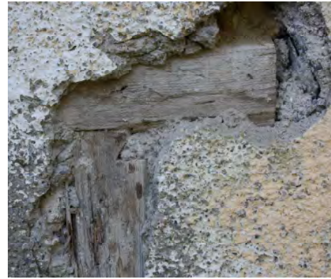
Abb. 104 (links) und Abb. 105 rechts): Vermauertes Fenster.
