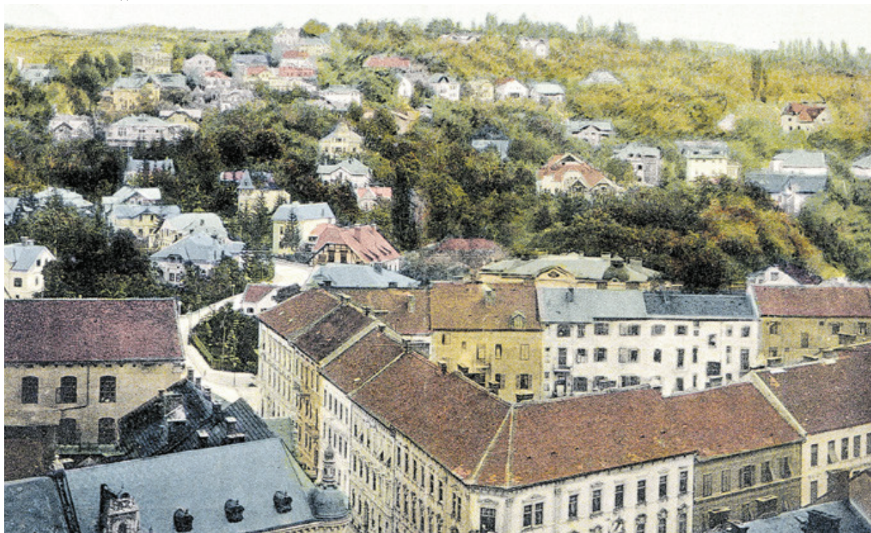
Stadtblick. Vom Turm der Herz-Jesu-Kirche auf die gründerzeitlichen Mietshäuser in der Nibelungengasse und auf die Villen am Ruckerlberg (um 1920).
