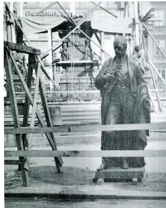
1976 und 2009 zur Renovierung demontiert.
