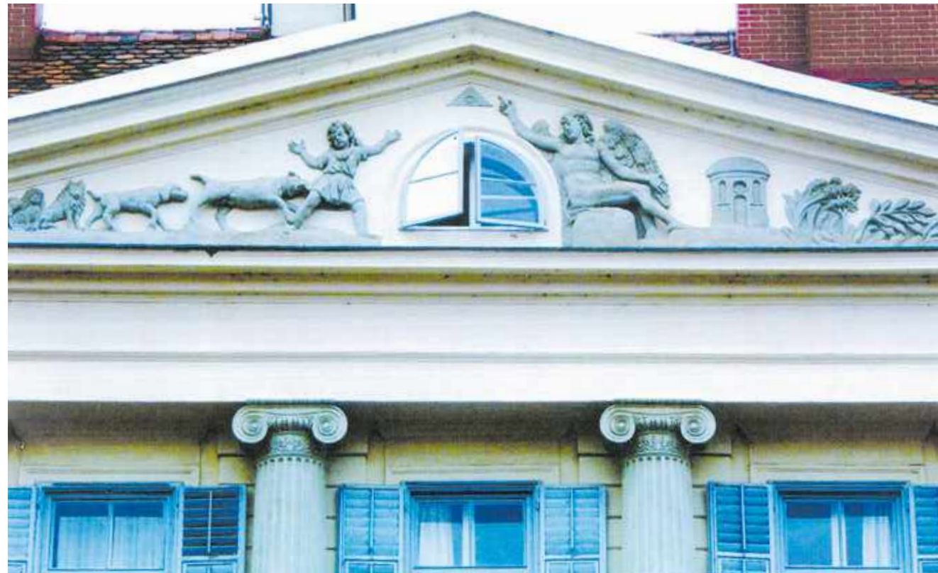
Leonhard Schönhofer lässt 1839 auf seinem Gebäude durch Baumeister Georg Lindner sein freimaurerisches Weltbild dokumentieren (Freiheitsplatz 4).
