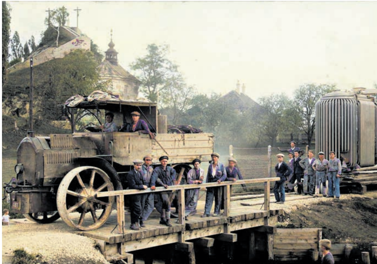
1931 wurde ein Transformator beim Umspannwerk Graz-Nord aufwendig transportiert. Im Hintergrund: der Kalvarienberg.
