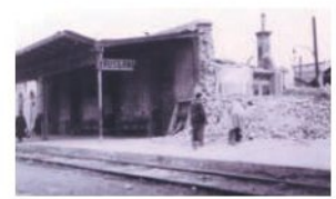
Vom bevorzugten Bombenziel Hauptbahnhof blieb 1945 nur eine Ruine
