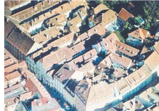
Die Ecke Sackstraße (links) – Sporgasse (rechts) ist ein Beispiel für die berühmte Grazer Altstadt-Dachlandschaft.
