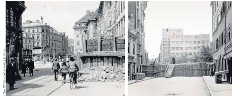
Die Panzersperren zwischen dem Rathaus und dem Haus Herrngasse 1 und Neutorgasse 32
