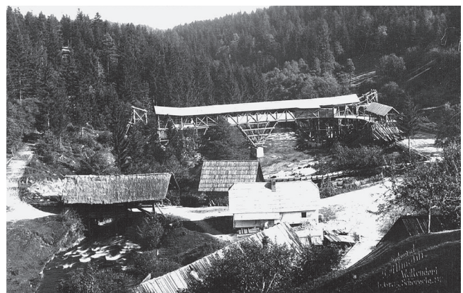
Abb. 5: Die „Ströhberne Brücke“ liegt an einer alten Straßenverbindung vom Kainachtal über den Herzogberg auf die Pack, wurde bereits in Landkarten des 17. Jahrhunderts eingezeichnet und überspannte bis 1949 die Teigitsch. Foto aus der Zeit vor dem Ersten Weltkrieg.
