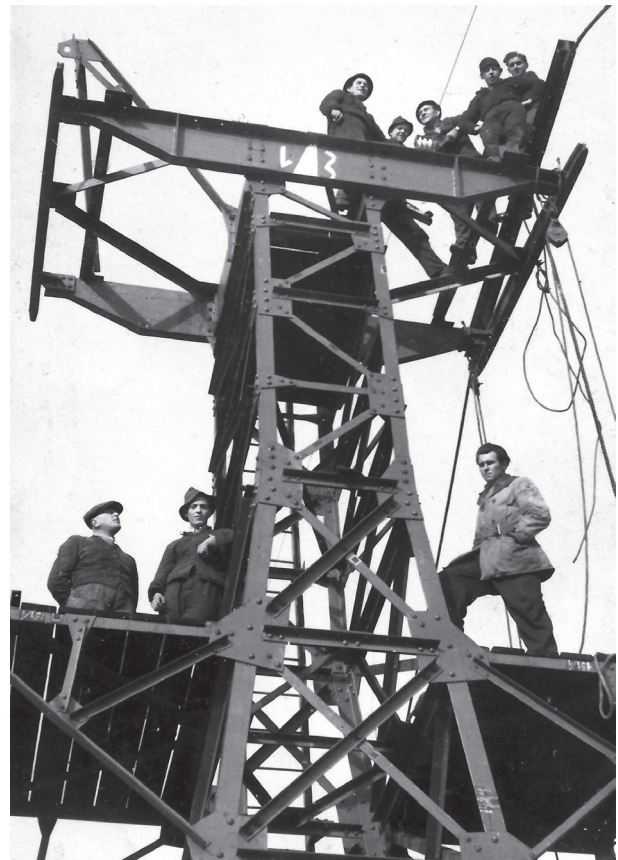
Abb. 5: Monteurpartie während des Baus der Schöckl-Seilbahn auf einer der Seilbahnstützen, 1950 Sammlung Johann Wallner, St. Radegund
