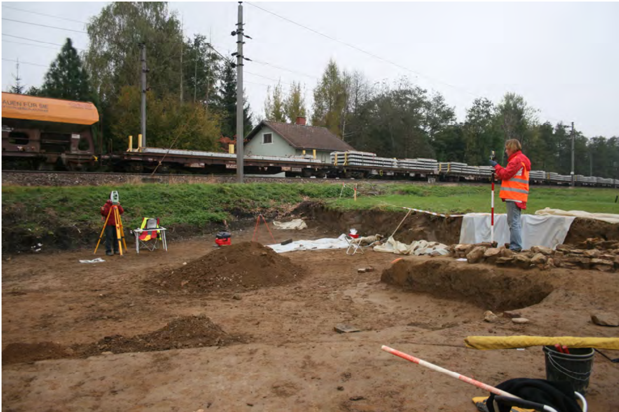
Abb. 65: KG Altenmarkt, Grabung im Zuge des Südbahnausbaus. Foto ARGIS, 23.10.2009, Bild Nr. 9623.
