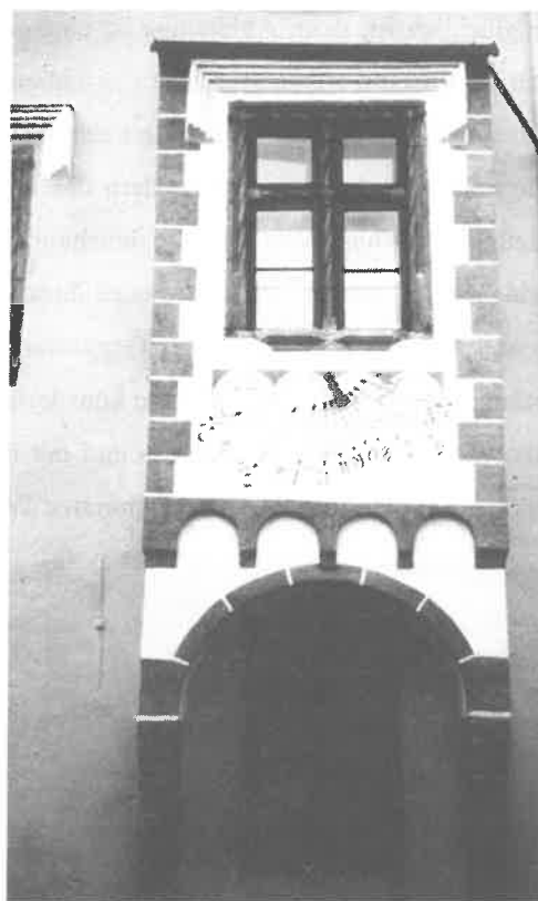
Abb. Nr. 3: Bad Aussee, Kammerhof Erker, Verputzte Steinarchitektur nach der Restaurierung der Originalpolychromie von der Wandgliederung (Putz) und den Naturwerksteinoberflächen. Foto Fladischer, Kindberg.
