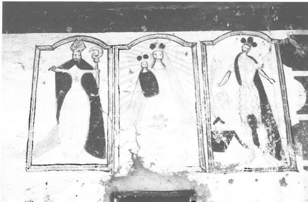
Bildergruppe vom vulgo Rauchegger in Gallmannsegg (Zustand vor der Restaurierung)
