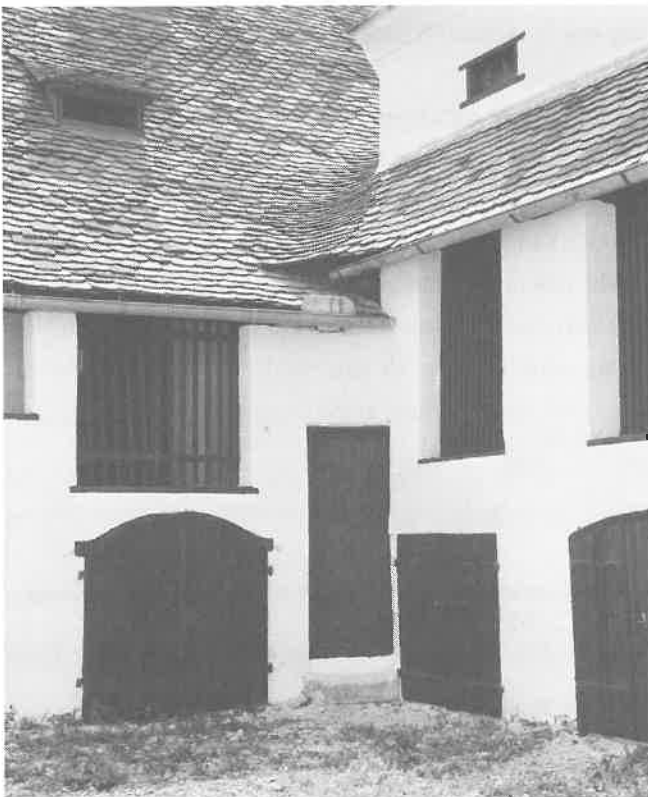
Die südwestliche Taborecke nach der Renovierung 1984
