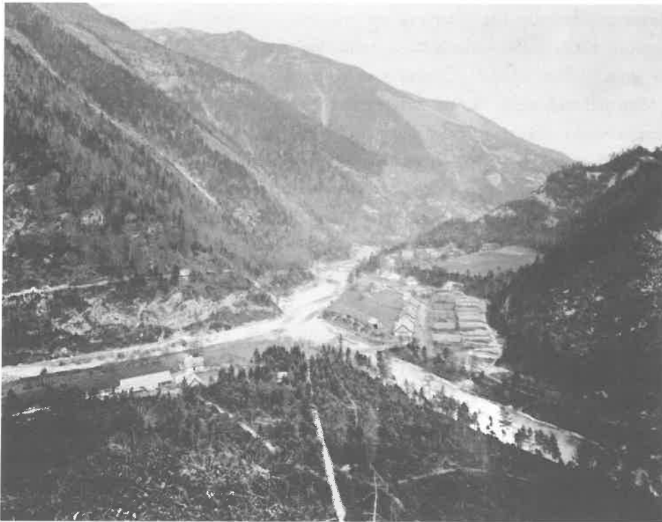
Ländkohlanlage in Fachwerk bei Wildalpen (Ende 19. Jahrhundert)
