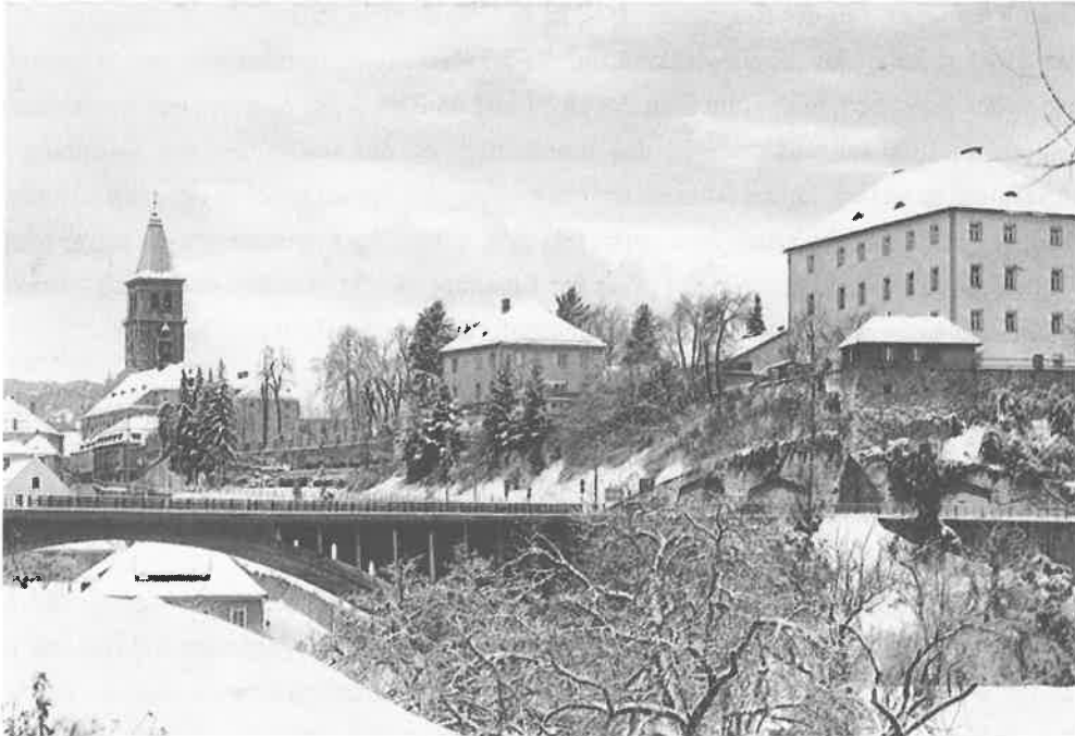
Südostecke der Judenburger Stadtmauer mit neuer Straße und Talbrücke, 1990
