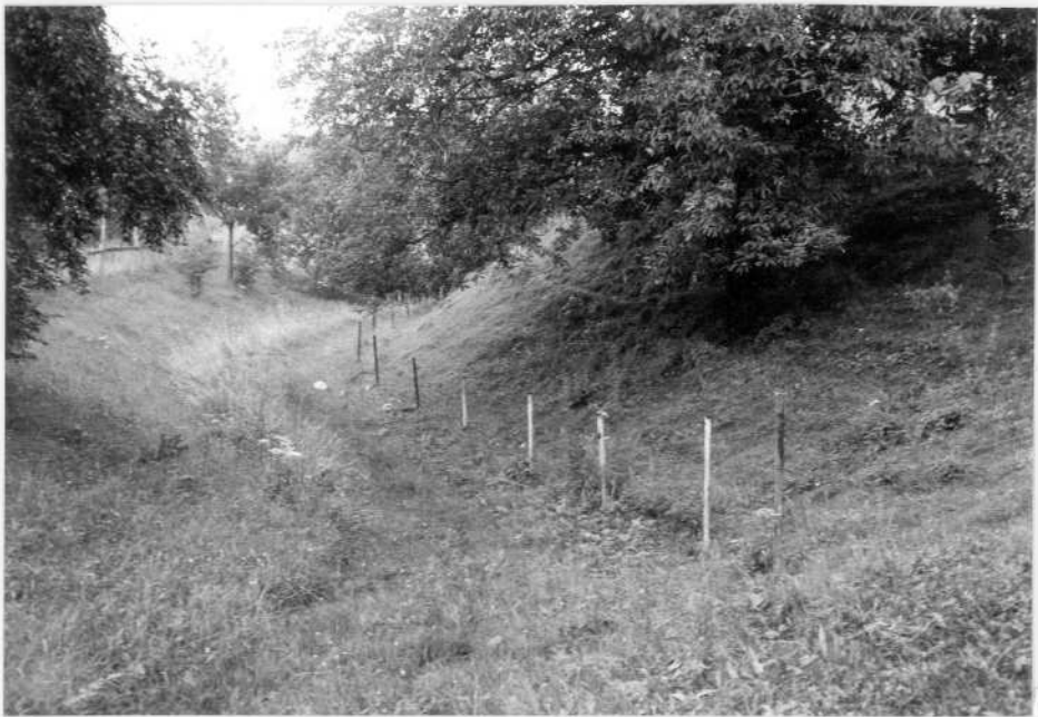
Abb.19: Entnahmegraben nördlich des Hausknechtkogels. Foto G.Fuchs.
