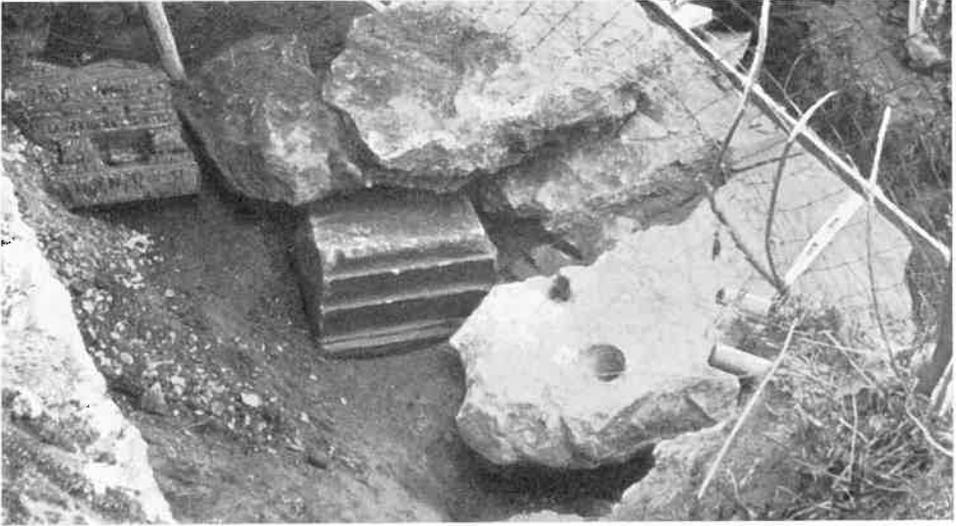
*Bild 1a: Mauer einer spätantiken Fluchtburg auf dem Frauenberg, die aus Bruchstücken römischer Bauten errichtet wurde.*
