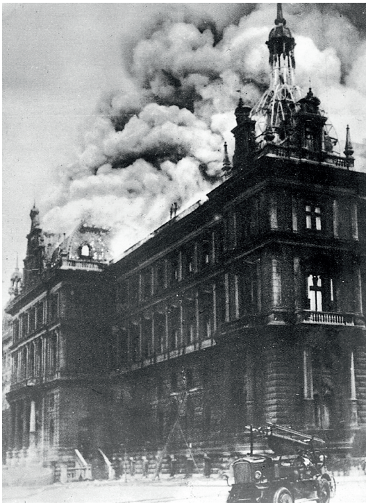
Abb. 5: Brand des Justizpalastes, 1927
